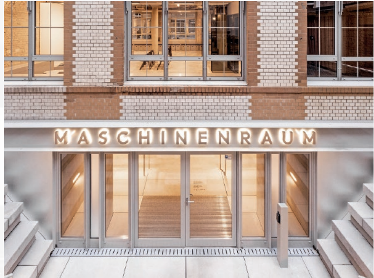
Der Maschinenraum befindet sich in einer umgebauten Fabrik.
